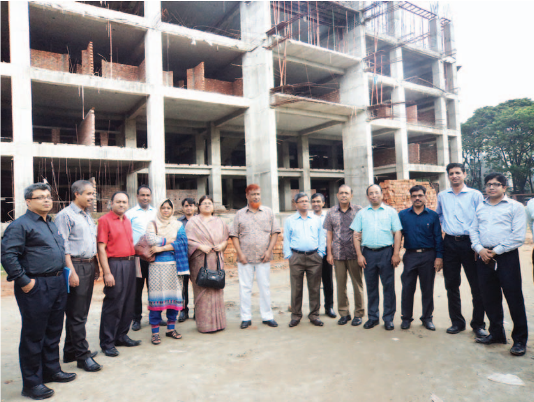
উর্ধ্বতন সরকারী কর্মকর্তাদের হাসপাতালের নির্মাণ কাজ পরিদর্শন
